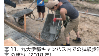
11. 九大伊都キャンパス内での試験歩道の建設(2018年)
