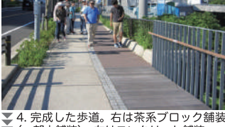
4. 完成した歩道。右は茶系ブロック舗装(一部木舗装)。左はコンクリート舗装
