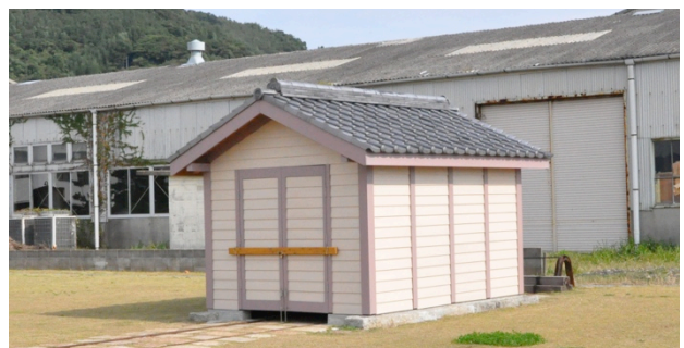
写真2 完成した倉庫。
